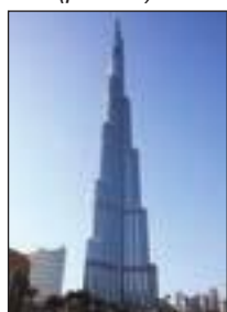
Рис. 57. Небоскреб в Дубае, высота 828 м, 163 этажа
